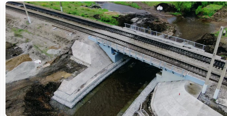
РЕКОНСТРУКЦИЯ МОСТА 1 И 2 ПУТИ НА 5891 КМ ПК6 ЗАБАЙКАЛЬСКОЙ ЖЕЛЕЗНОЙ ДОРОГИ
