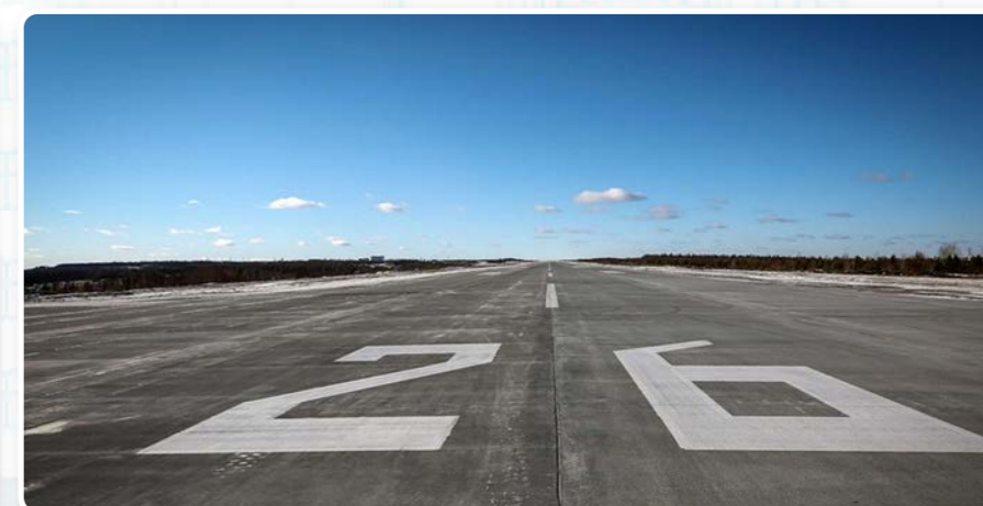
ЗАВЕРШЕНА РЕКОНСТРУКЦИЯ ВЗЛЕТНО-ПОСАДОЧНОЙ ПОЛОСЫ В РЕСПУБЛИКЕ САХА (ЯКУТИЯ), Г. НЕРЮНГРИ
