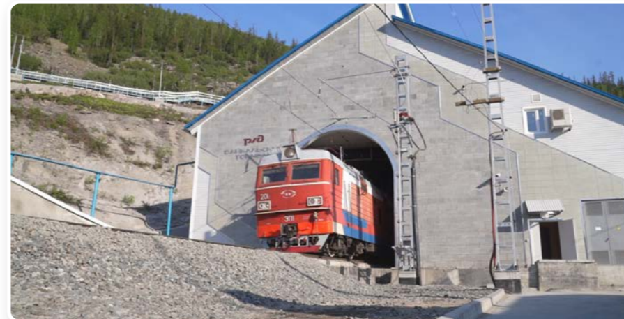
ТОРЖЕСТВЕННОЕ ОТКРЫТИЕ НОВОГО БАЙКАЛЬСКОГО ТОННЕЛЯ
